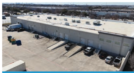
Project Stemmons DALLAS, TX
